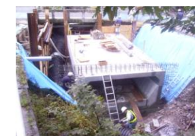
ボックスカルバート施工状況
