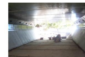
護岸・護床ブロックの施工状況
