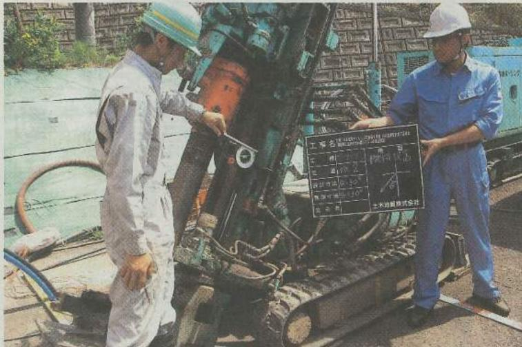
斜め掘削工法（自社敷地内に地中熱冷暖房システムを導入するための熱交換井を掘削す
