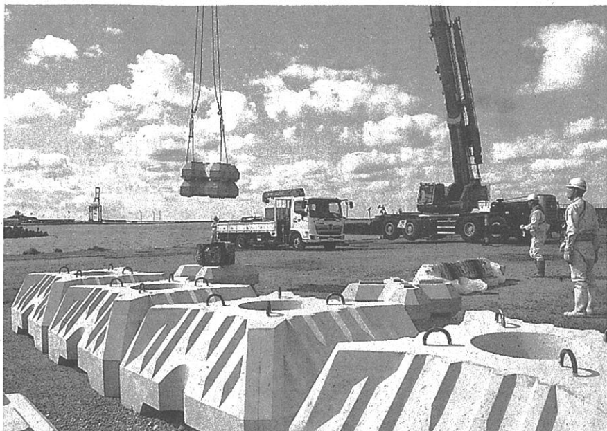
ブルーインフラ実証実験で使うブロック(手前)はクレーンでつり上げられ、港内に沈められた18日、酒田市の酒田港
